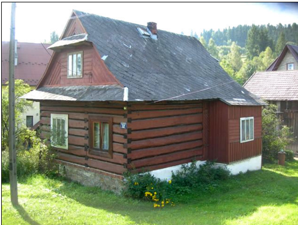
Rys. 3. Zdjęcie obrazujące wykorzystywanie wyrobów azbestowo-cementowych jako element pokrycia dachowego (płyty karo).
